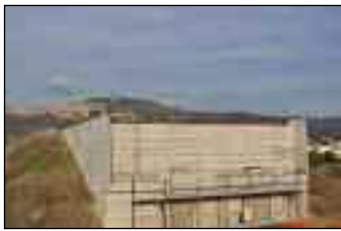
La spalla lato Cortona
