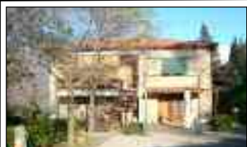
CORTONA: A 2 passi dal centro (raggiungibile a piedi), villa ristrutturata suddivisa in 2 unità abitative indipendenti. Immobile dispone di giardino, annessi accatostati ed uliveto. Stupenda vista panoramica. € 690.000 Rif. 126
