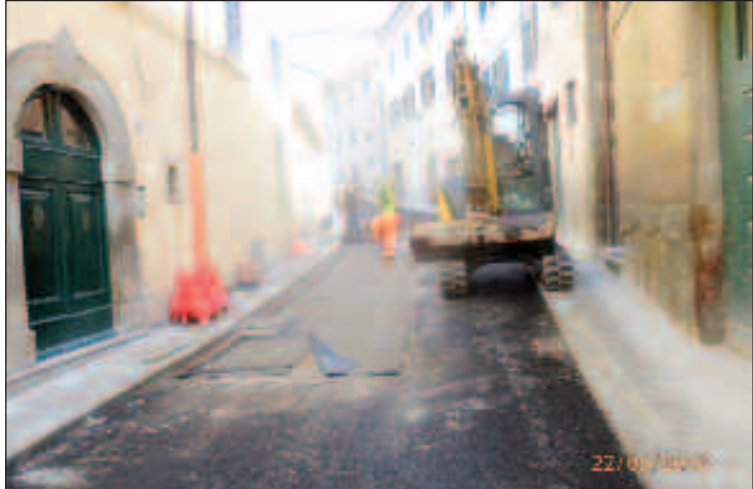
Nuovi lavori dopo asfaltatura in Via Severini
