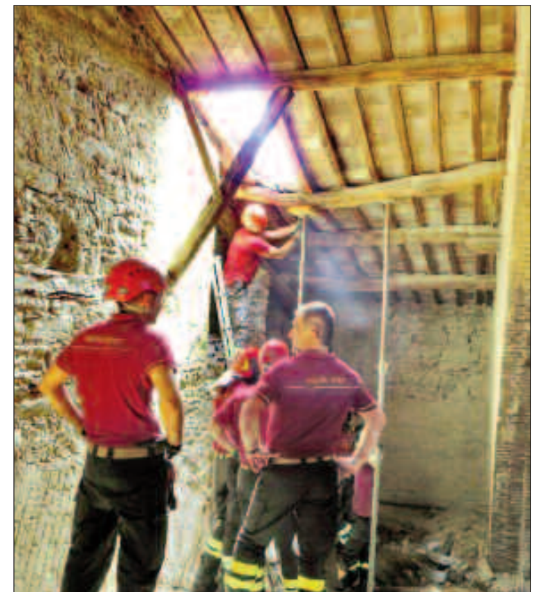
I Vigili del Fuoco al lavoro all'interno della volta della Chiesa del Calcinaio
