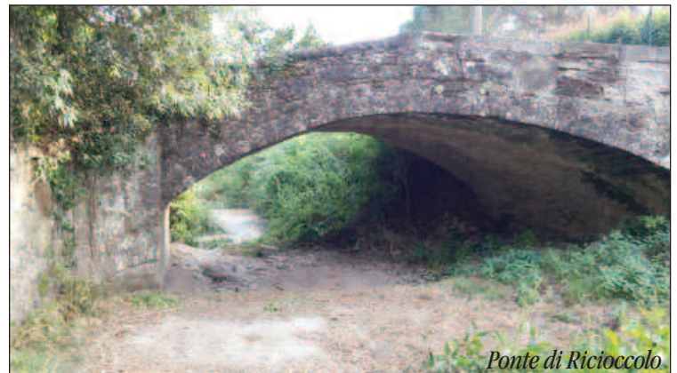
Ponte di Riccioccolo
