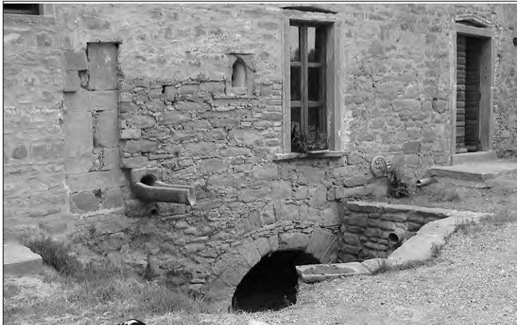
Il canale di deflusso dell'acqua ancora al mulino Valiani.
