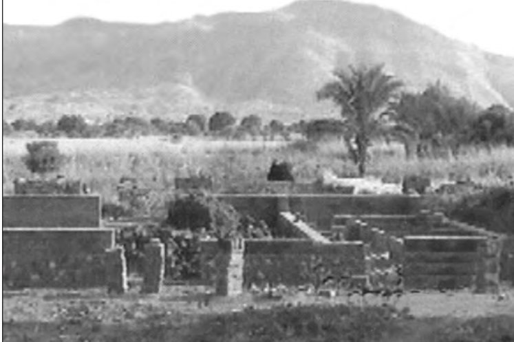
Moba, Repubblica Democratica del Congo. Stato di avanzamento dei lavori al luglio 2005
