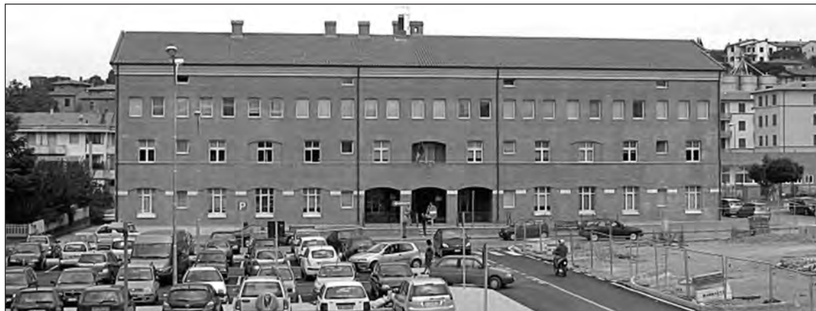
La nuova sede Distrettuale di Camucia
