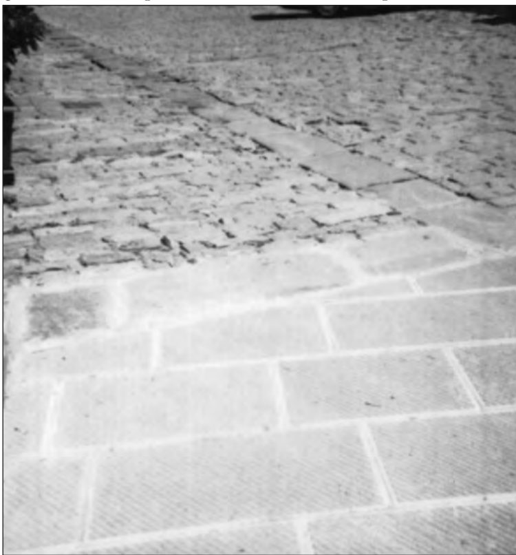
La nuova pavimentazione all'imbocco della vecchia piazza
