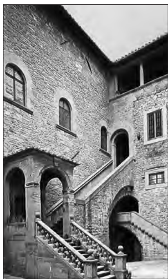
Palazzo Casali, cortile interno (se. XIII)
