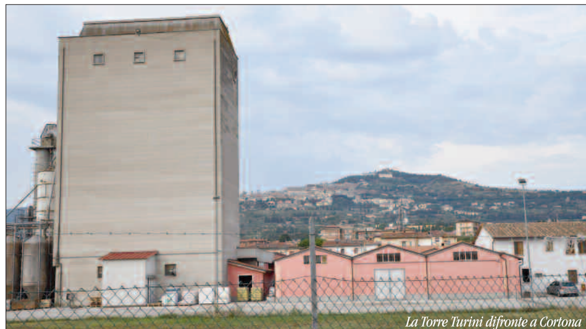
La Torre Turini di fronte a Cortona
