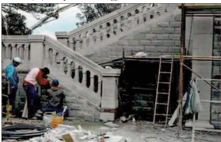
(14) Scalinata realizzata con attenzione all'ambiente
