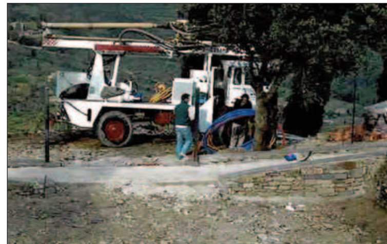
(6) Operai al lavoro
