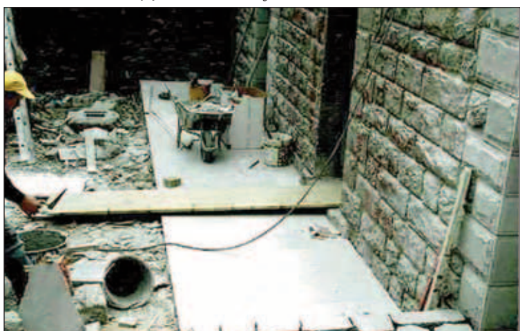
(10) Dal vecchio acquedotto si ricava l'area del bar-ristorante
