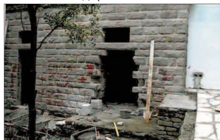
(9) Dal vecchio acquedotto si ricava l'area del bar-ristorante
